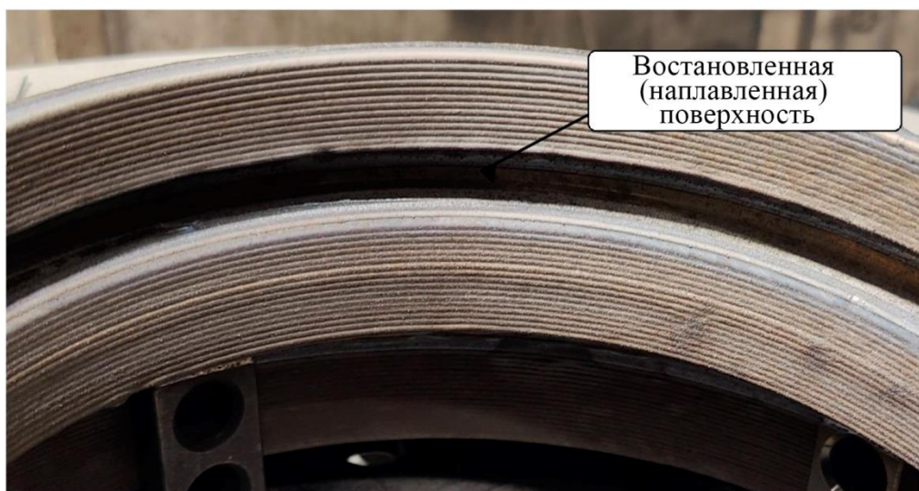
Рис. 7. Восстановленные поверхности подшипникового щита после наплавки
