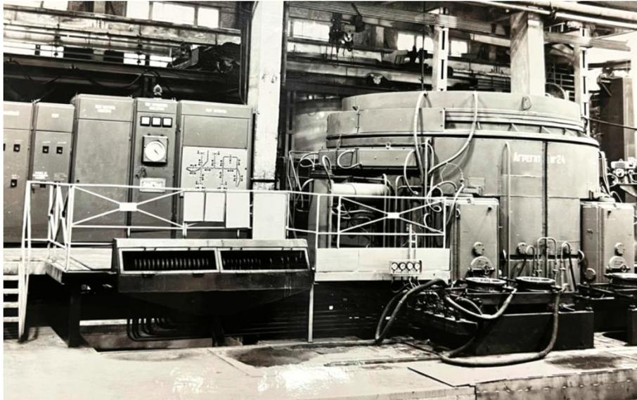
Рис. 5. Вакуумный миксер для рафинирования расплава
